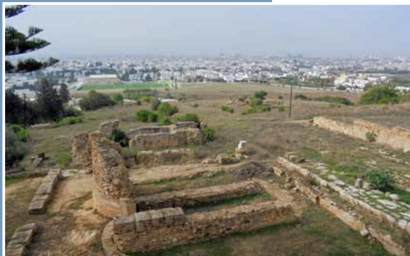
III. 40. Menaces urbaines sur le site de Carthage. © IPW/AWaP
